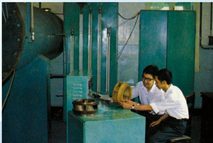
水轮机气蚀试验
